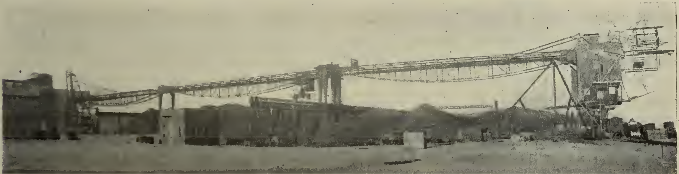
Fig. 109. — Transporteur à pont du port de Duluth.
