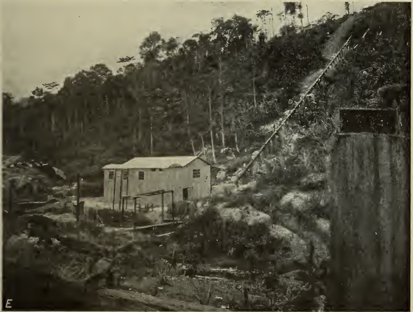
Fig. 17. — Vue générale de l'usine d'Ulu Guroh.
