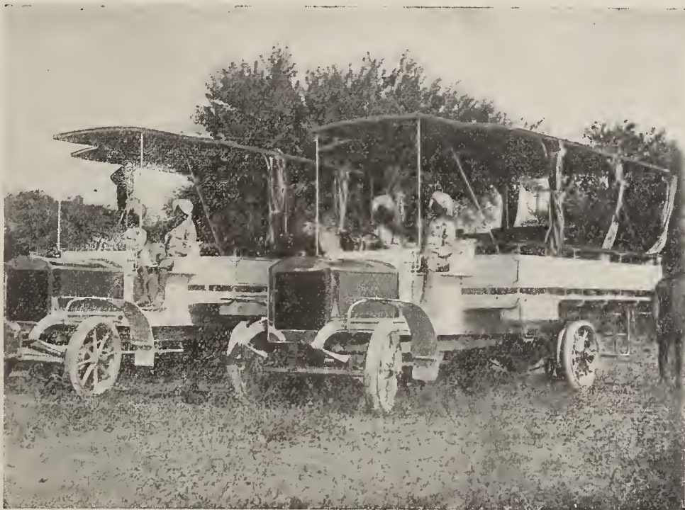
Fig. 56. — Omnibus pétroléo-électrique, système Tilling-Stevens, en service aux Indes.
