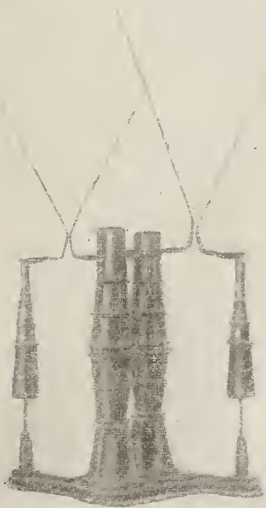
Fig. 194. — Parafoudre « Sig » pour 90 000 volts, type A.
