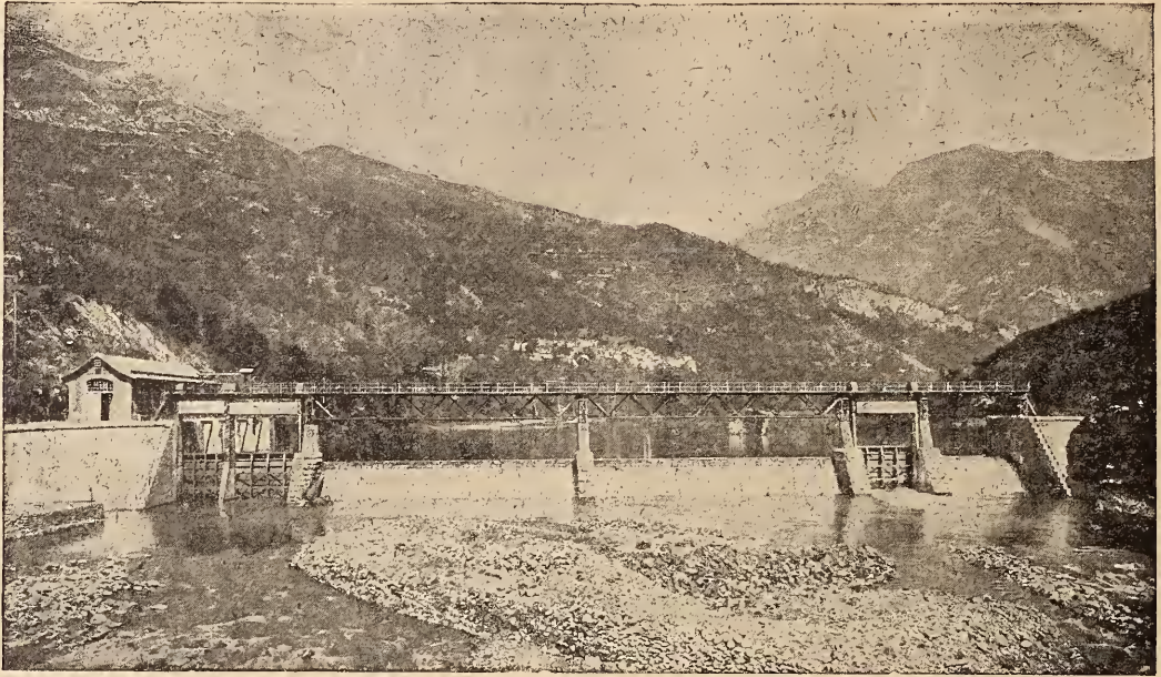
Fig. 1. — Bassin de retenue. Vue en amont avec pavillon de manœuvre des vannes à gauche.
