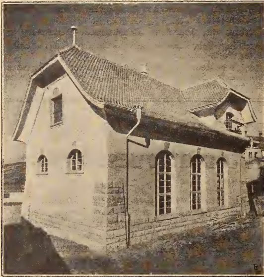
Fig. 1. — Sous-station automatique Brown-Boveri, de Riehen (Suisse).
