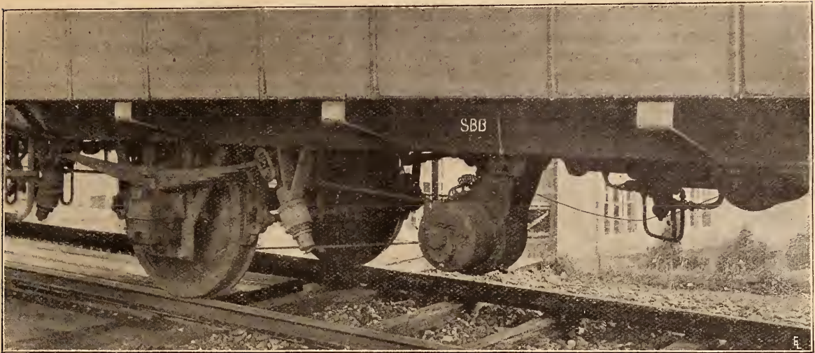
Fig. 3. — Vue de l'installation d'une dynamo génératrice Brown-Boveri.
