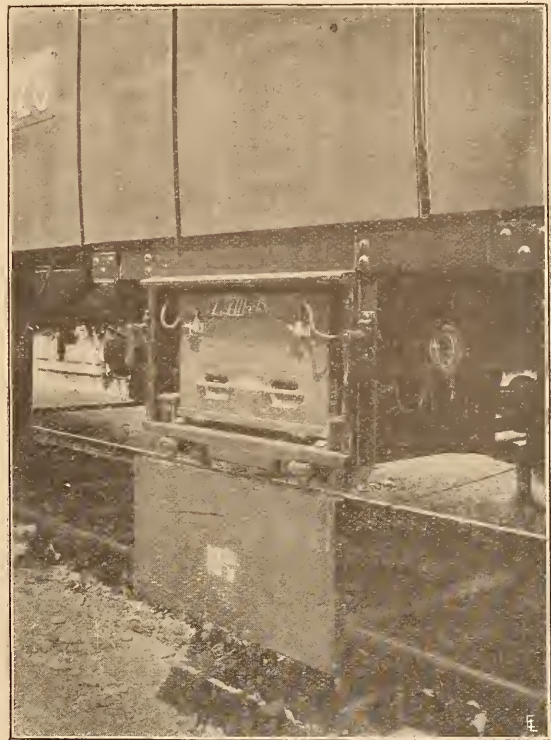
Fig. 3. — Montage et disposition des coffres renfermant les accumulateurs.
