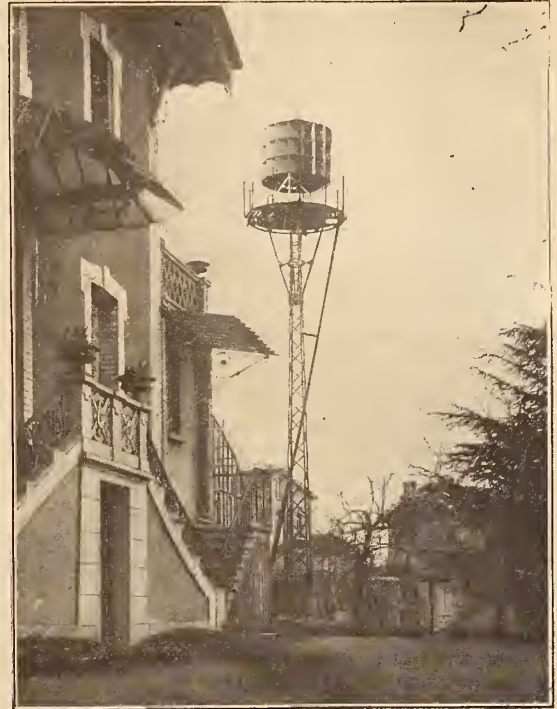
Fig. 8. — Turbine à vent Lafond,
