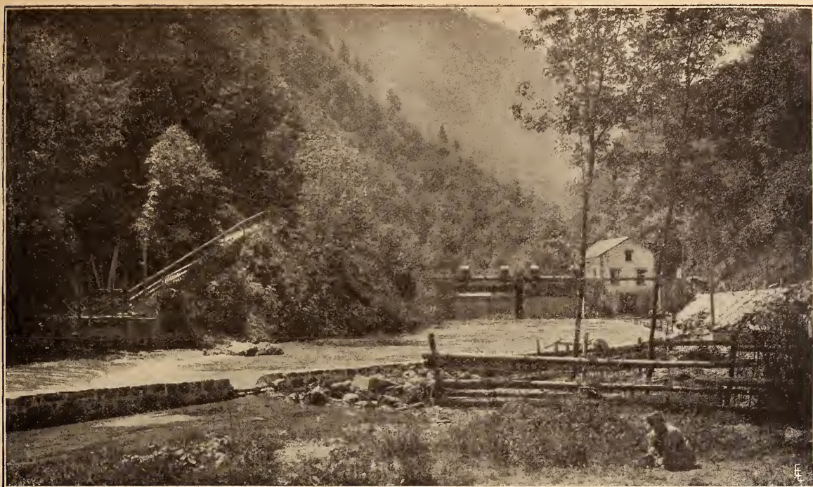
Fig. 4. — Barrage sur l'Arly.
