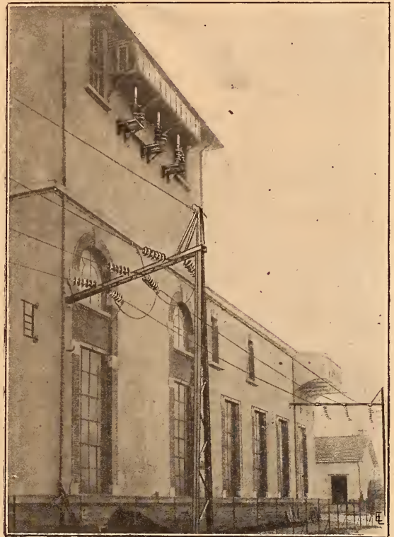
Fig. 13. — Arrivées de lignes du poste de Pouxoux.
