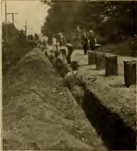
FIG. 1. DIGGING TRENCH FOR CONDUIT
