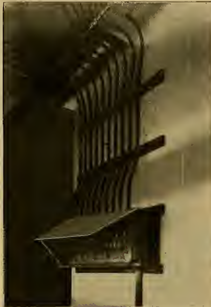
Distribution Box and Conduit
