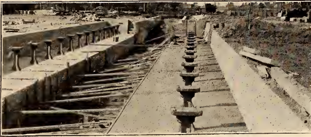
FIG. 19—CONCRETE FOUNDATION OF THE CINDER PIT— C. & E. I. R. R.
