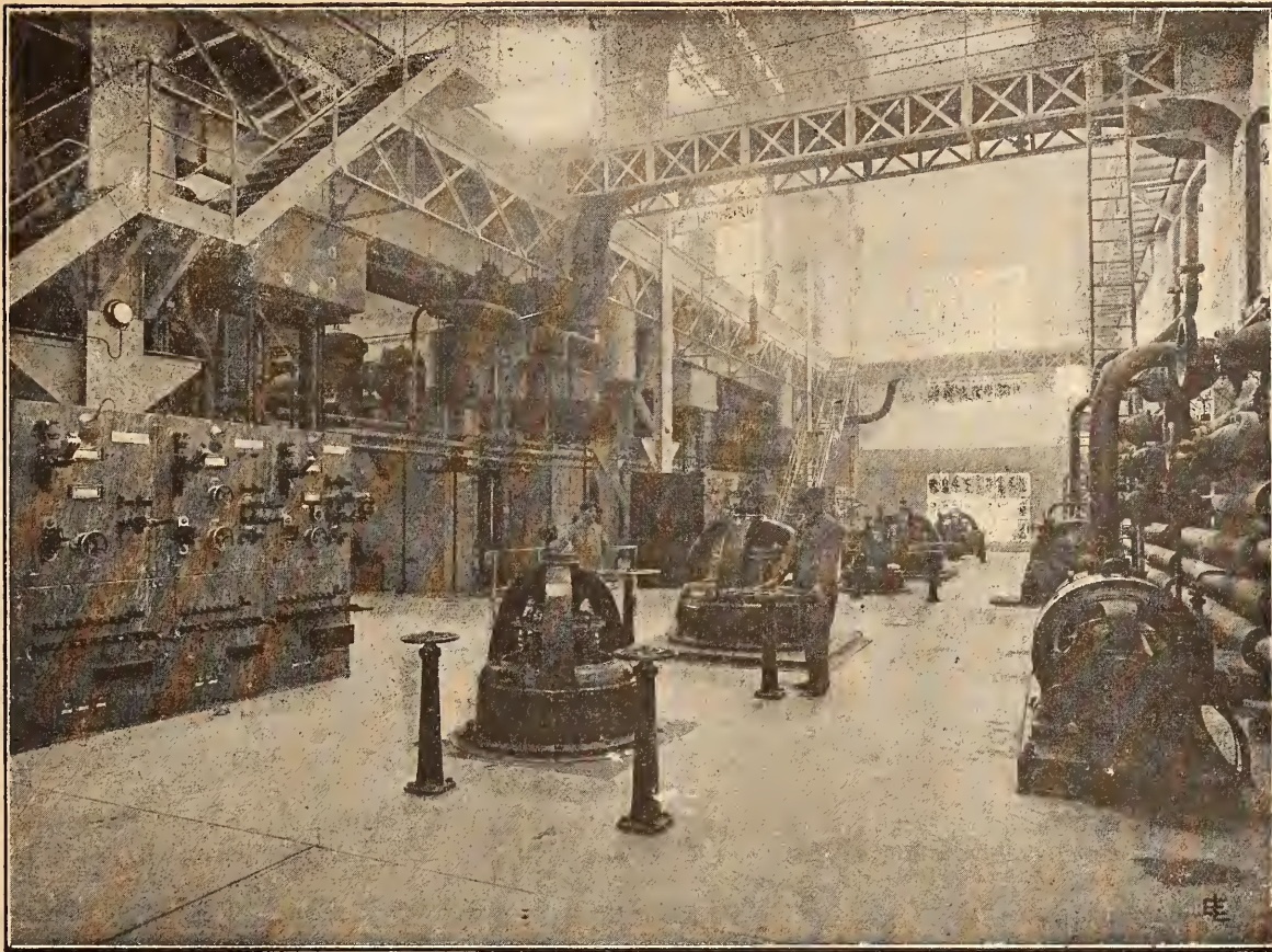
Fig 3. Salle des services auxiliaires de l'usine Nord (C. P. D. E.)
